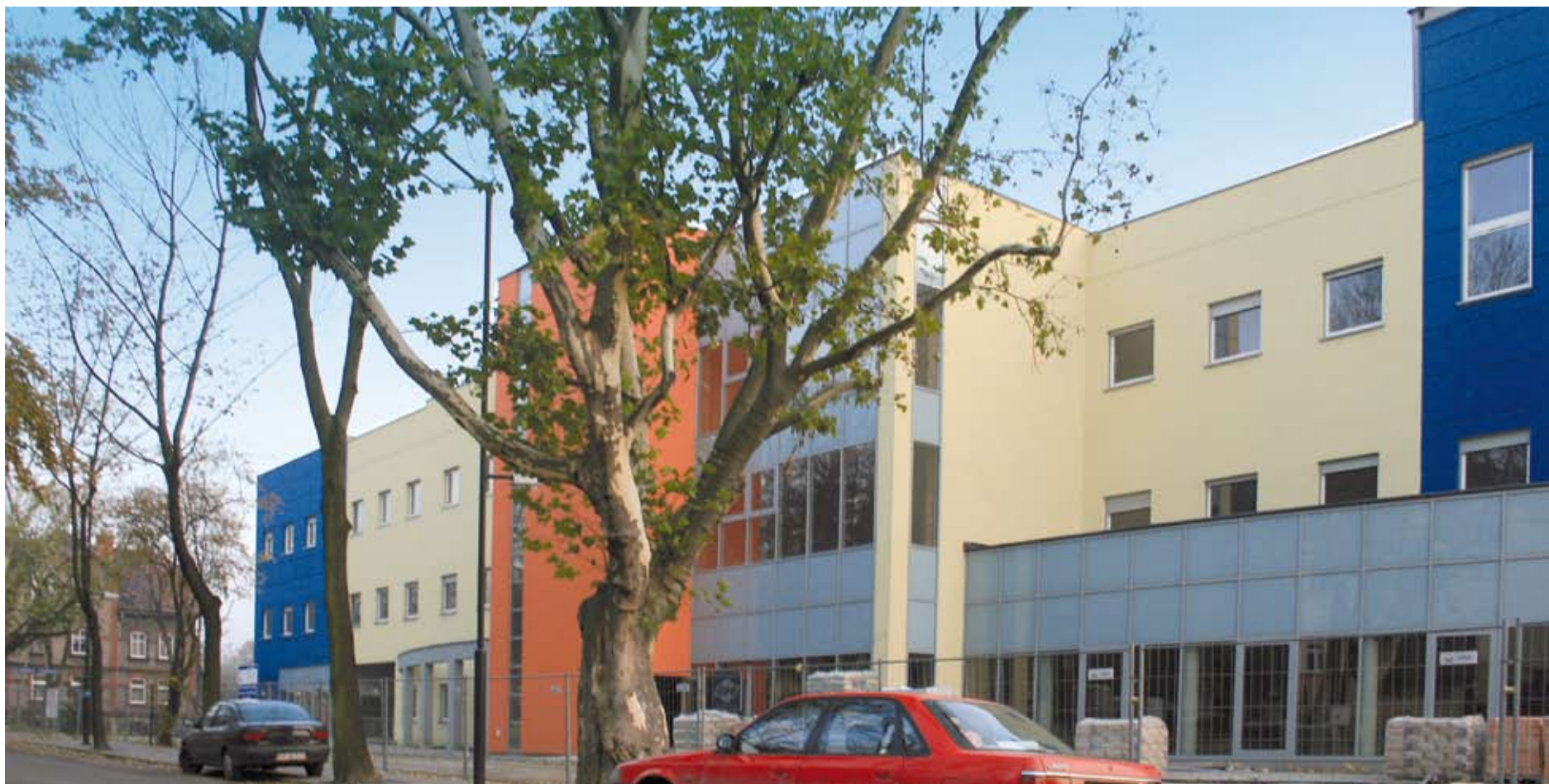
Nowy budynek Śląskiego Centrum Chorób Serca (widok z ul. Jagiellońskiej)
